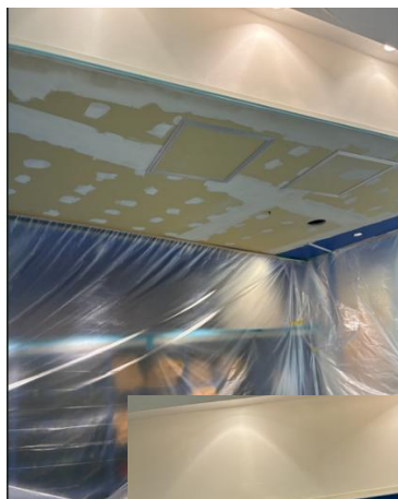
フロント前、空調現状復旧
